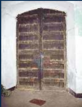
Batents interiors de la porta principal de la masia, amb els forrellats i les baldes de ferro. Foto: Toni Castellà, 2006
